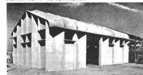
Entrepôt expérimental en ferrociment pour la sté industrielle Nervi et Bartoli à Rome, 1946. Murs et couvertures ont une épaisseur de 3 cm. La résistance est donnée par le plissement des surfaces.
