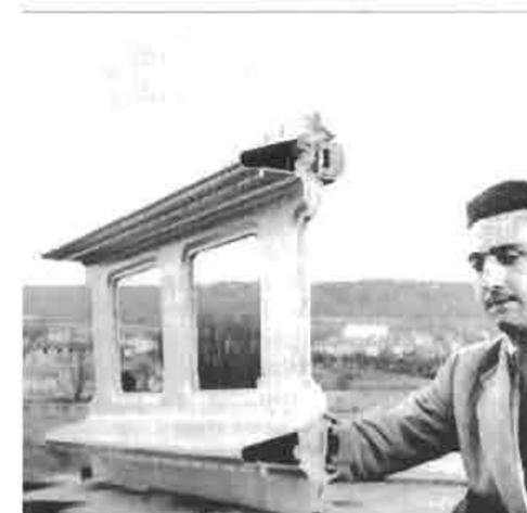
Présentation d'un prototype de panneau de façade en aluminium plié à l'usine de Maxéville, Prouvé.
