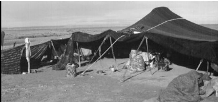
Le habitats nomades et les tentes, par leur capacité à se plier pour occuper un minimum d'espace, laissent libre cours au vagabondage des Hommes. Les tentes touareg par exemple, sont conçues pour être transportables par un chameau. La structure tissée des yourtes également, est faite pour se replier en un volume réduit, ainsi que l'enveloppe de toile et de feutre. car la yourte accompagne les mongols dans leurs migrations, à dos de cheval.
